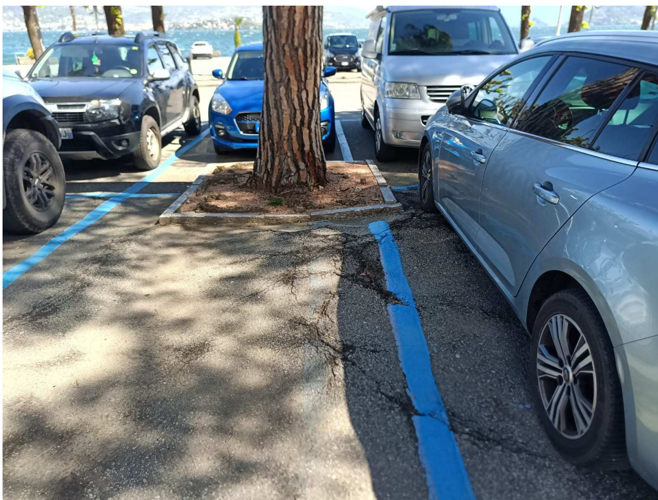
FOTO IIIII – PARTICOLARE DEI CORDOLI AMMALORATI
