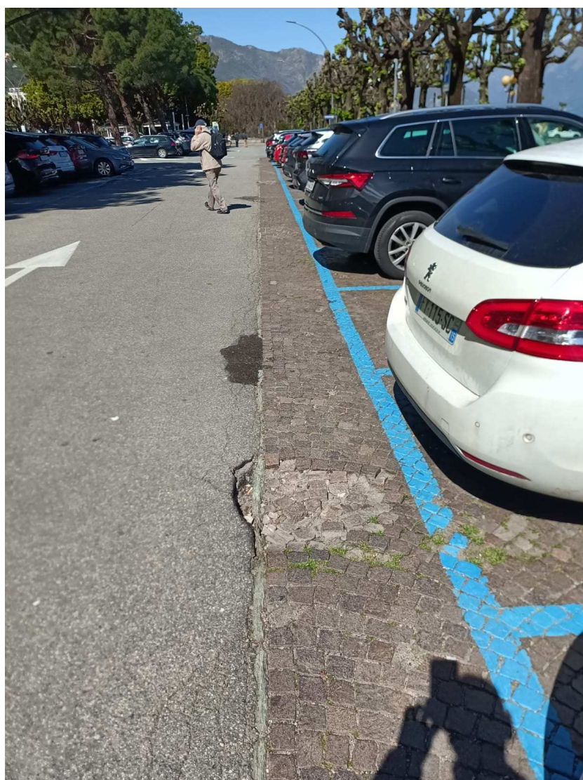
FOTO IVV – PARTICOLARE SULLA PORZIONE DI PAVIMENTAZIONE IN PORFIDO AMMALORATA
